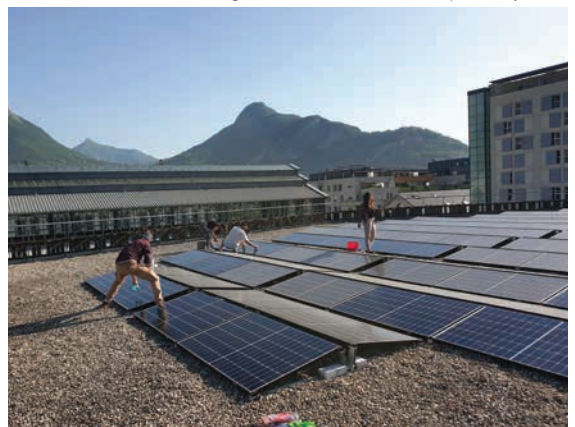
Opération de nettoyage réalisée lors d'un test de qualification des algorithmes de détection des salissures, par Heliocity
